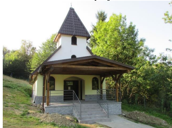
Po realizácii projektu:
